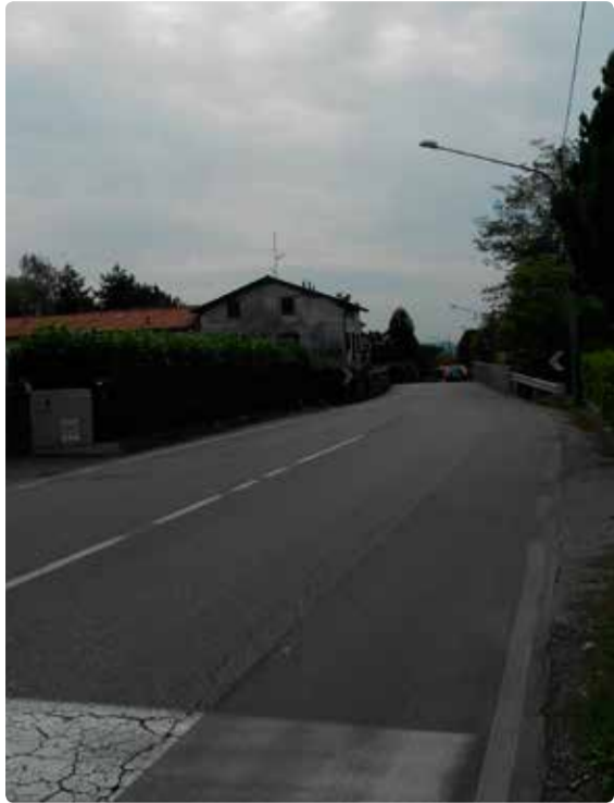
Belvedere - il ponte della ferrovia
