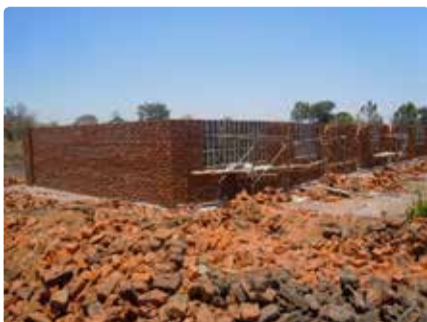
I lavori alla scuola NAMITONGA a KAMWENDO, dedicata al compianto Maurizio
